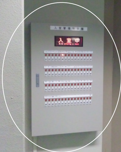
入退室監視盤
